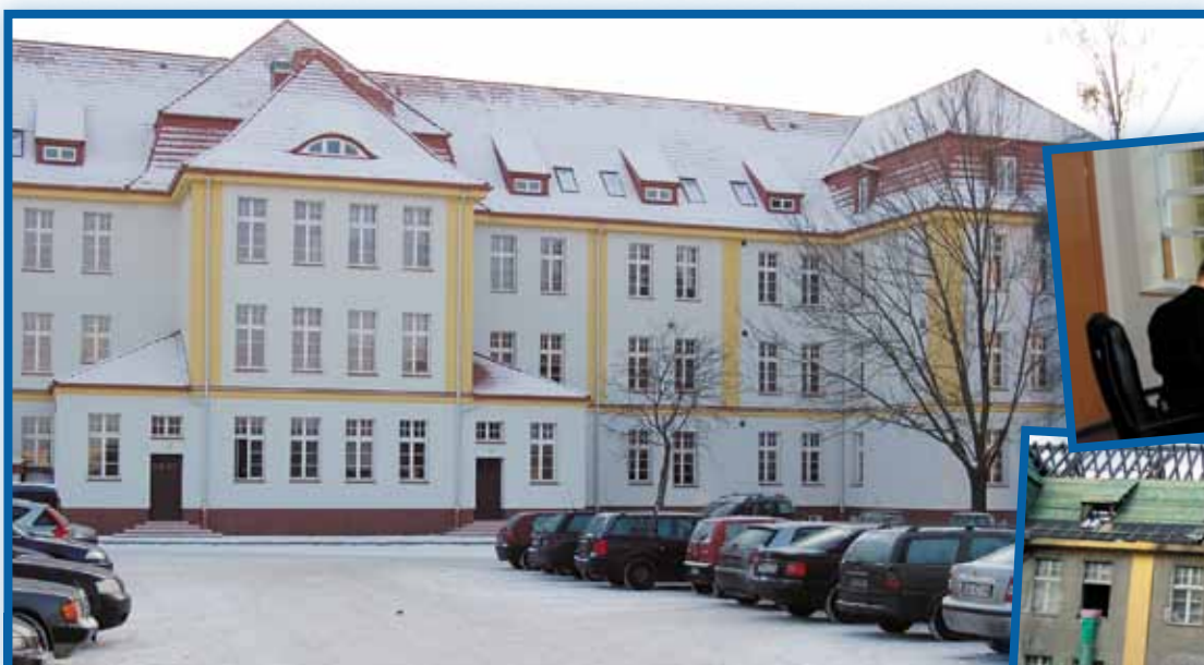
Nowo wyremontowany budynek na potrzeby OPP w Olsztynie
